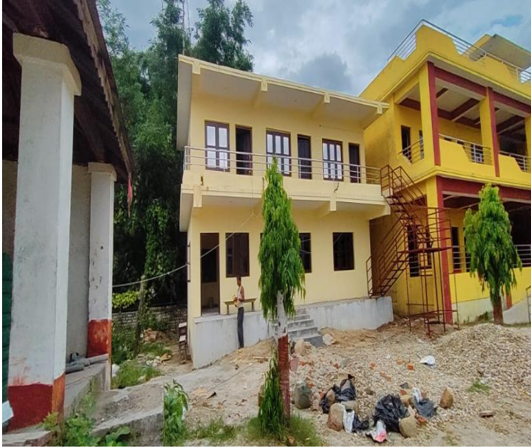
हडिया स्कूलमा क्यान्टिन निर्माण वडा नं.९
