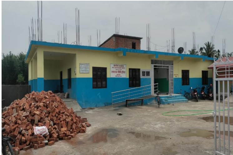
स्वास्थ्य चौकी भवन निर्माण वडा नं.९
