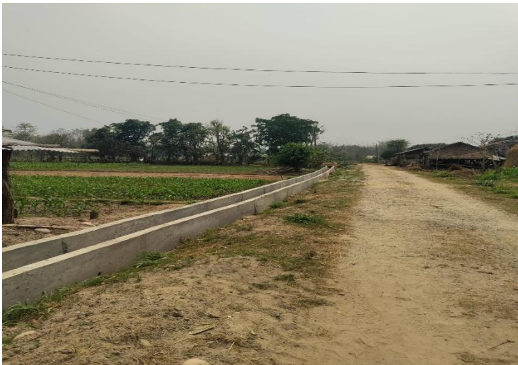
खोरिया टोल बस्नेत घर छेउ नाली निर्माण
