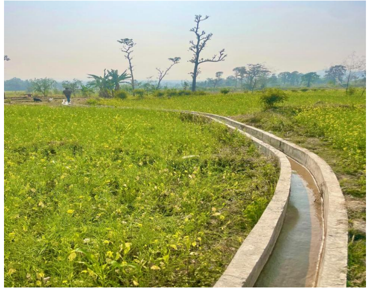
लामा खोला सिँचाई कुलो वडा नं.२
